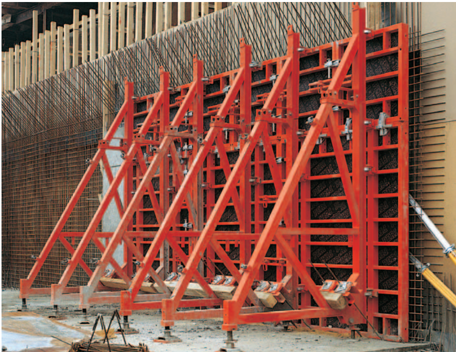
Le unità di contrafforte SB-B e SB-C, in combinazione con la cassaforma a telaio TRIO, per un'altezza della cassaforma pari a 3,90 m.
