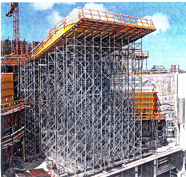
Cancelleria di Berlino: impalcature a torre PD 8 alte fino a 18,00 m, utilizzate come sottostruttura di una cassaforma.
